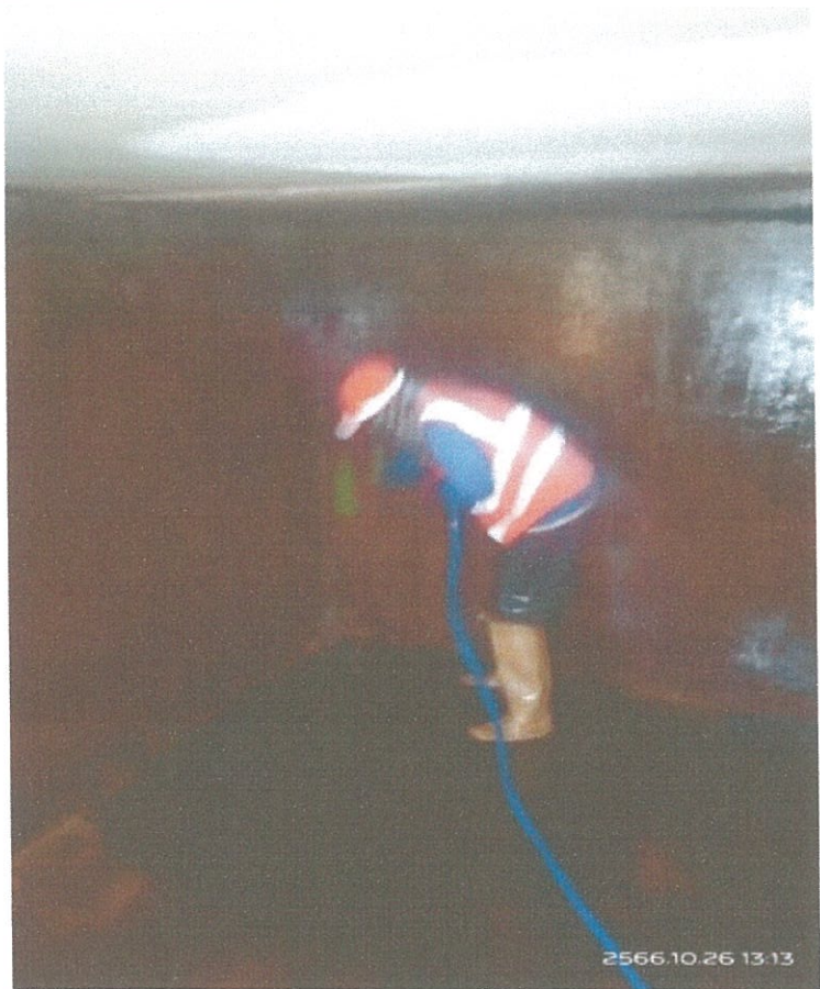
ภาพพนักงานขัดผนังและใช้น้ำสะอาดฉีดล้าง
