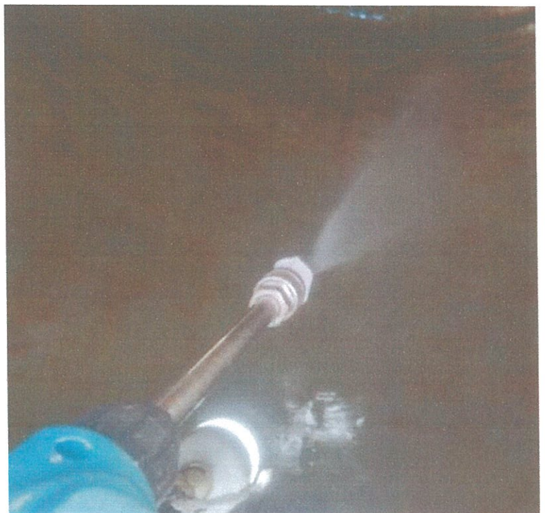
ภาพทำการฉีดพ่นคลอรีนฆ่าเชื้อโรค
